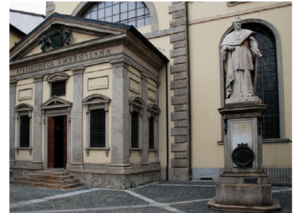
Fachada de la Biblioteca Ambrosiana , Milán.
